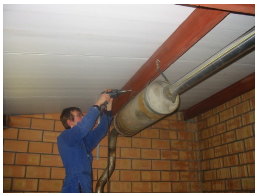
Figuur 34: montage uitlaat
