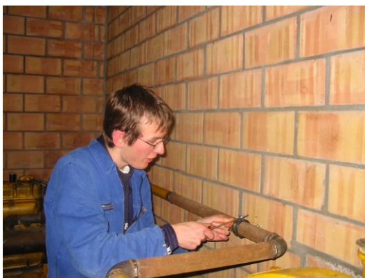
Figuur 37: montage buizen
