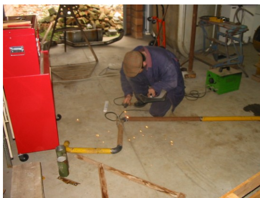
Figuur 36: lassen van de buizen
